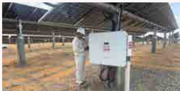
现场调试与维护
